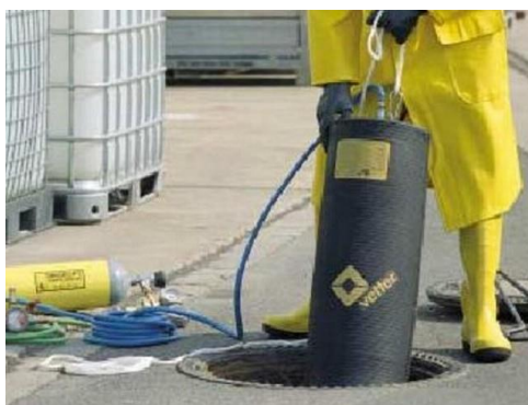
5.ábra: Csőelzáró elhelyezése ipari aknában [10]
