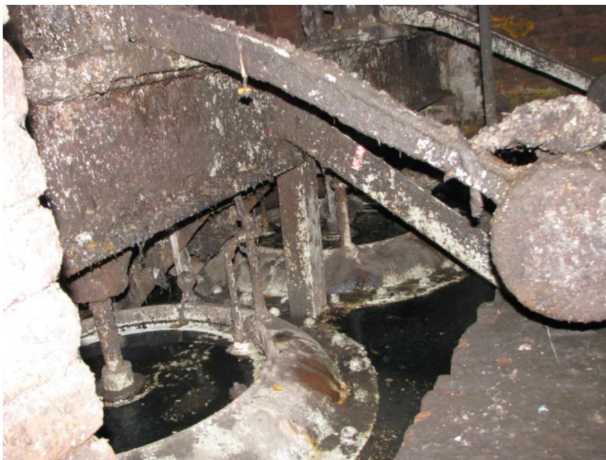
6.kép, Beépített tányérszelepek a Pesti-oldali Duna-parti Főgyűjtőn
